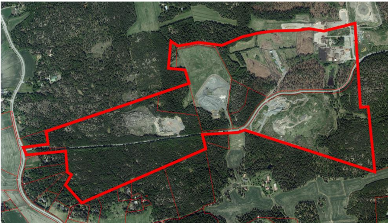
Ilmakuva alueesta. Alueen vasemmalla puolella Maskuntie, alueen halki kulkee Isosuontie.
