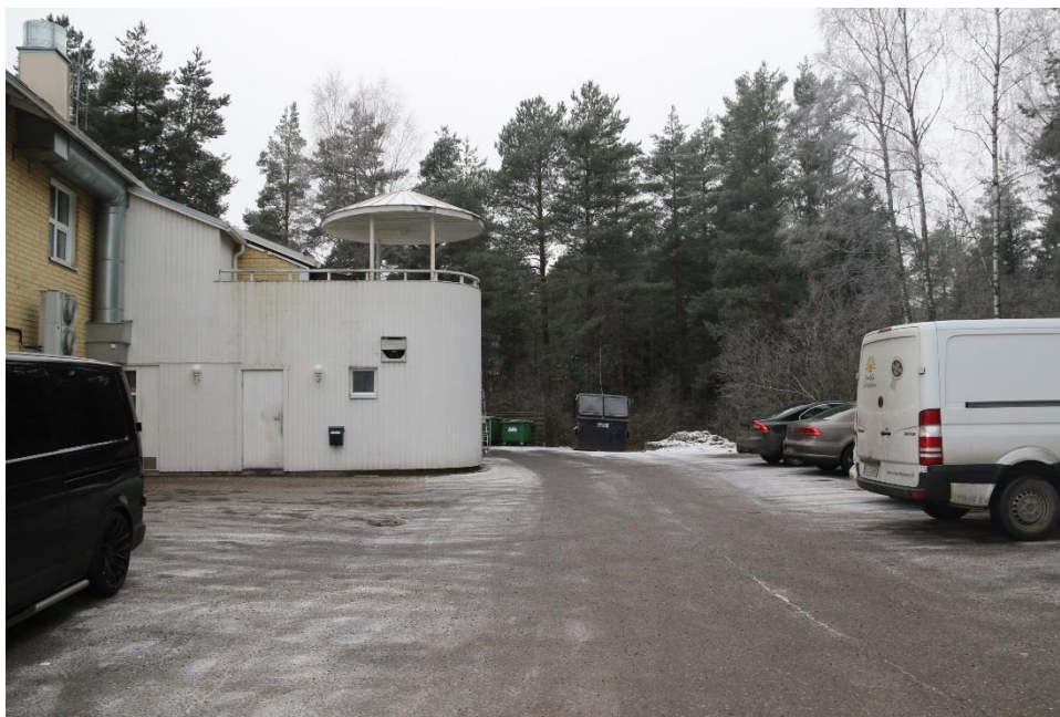
Ruotupihan tuleva katulinjan kohta kuvattuna länteen.
