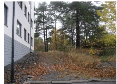
Kuva korttelin laajentumissuuntaan päin. Vasemmalla palvelutaloa D, pohjakerros on upotettu maastoon.
