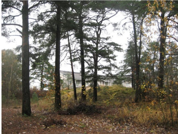
Näkymä palvelutalo D:n luoteispuolelta kohti kiinteistön 3-36-2 asuinkerrostaloa.
