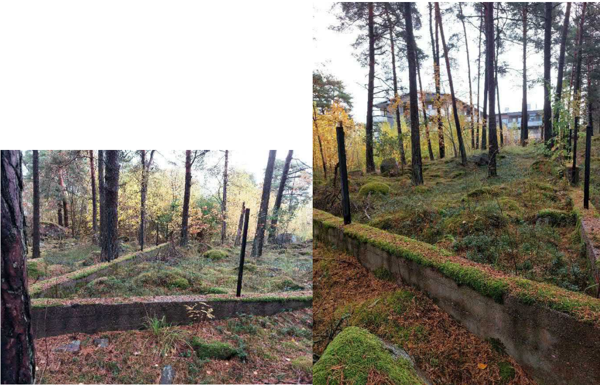
Kuvat 17-18. Selvitysalueen keskiosissa on betoninen aitarakennelma (Kuva 1: rakennelma)
