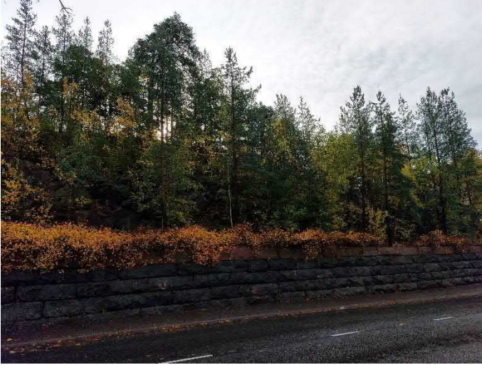
Kuva 2. Näkymä Käsityöläiskadun puolelta. Rinteessä on nuorempaa puustoa kuin mäen yläpuolella.
