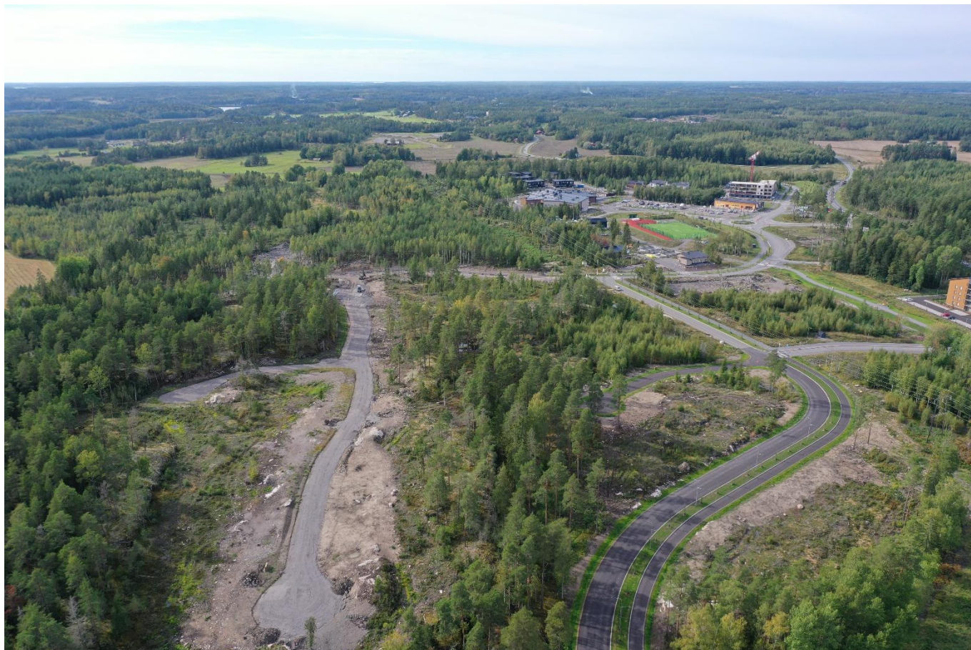
Drone-kuva Aurinkotuulen alueen itäreunalta elokuulta 2024. Kuvassa näkyvät kesällä 2024 valmiiksi rakennetut Luode- ja Taivaankansi-kadut, sekä tuolloin vielä keskeneräiset Pyrstötähti- ja Tähdnlento-kadut. (Alkuperäinen kuva: Veijo Lindgren)
