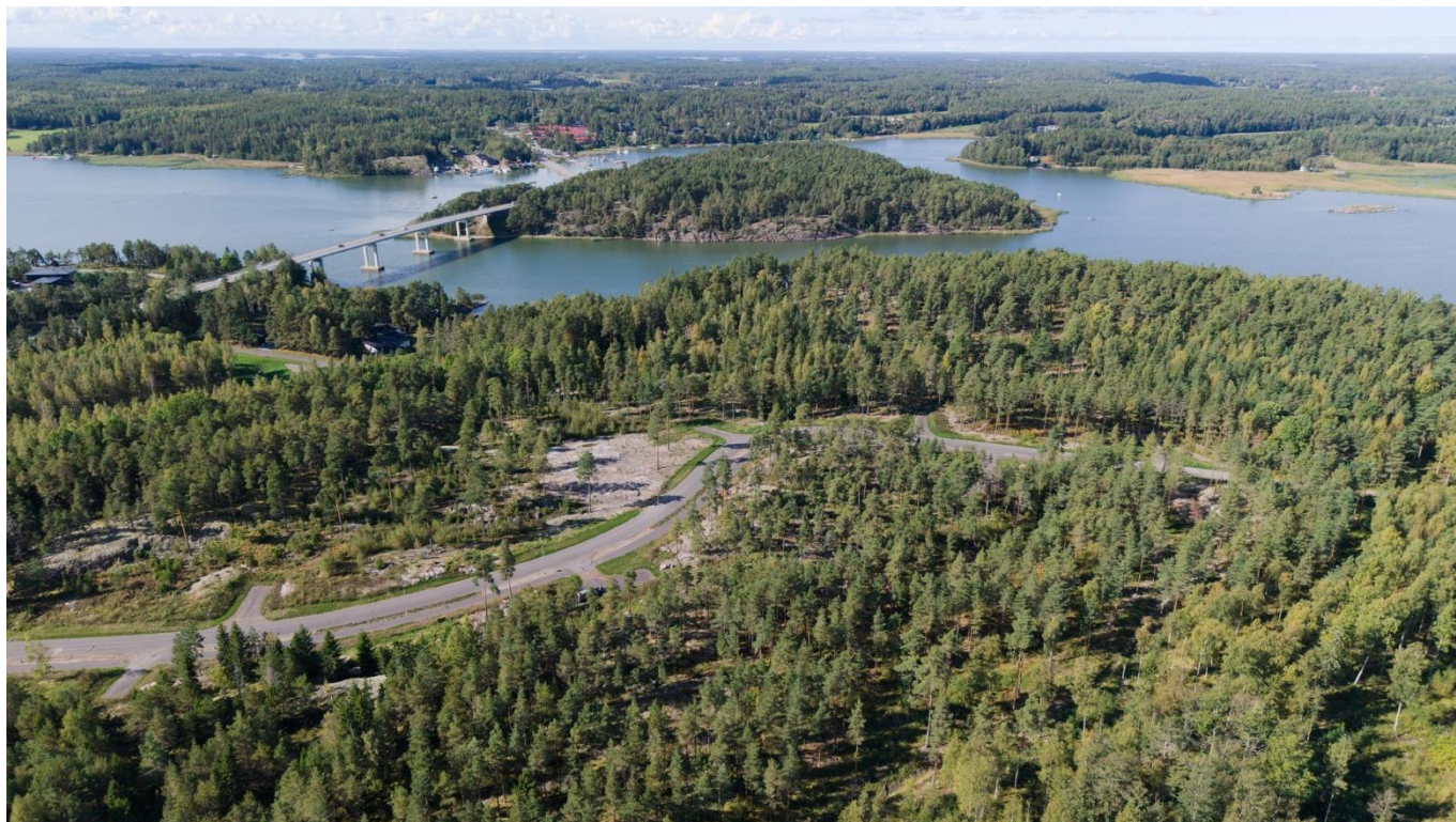
Drone-kuva Sokon alueesta syyskuulta 2026. Kuvassa näkyvät kesällä 2026 valmiiksi rakennettu Viittatie, sekä taustalla Särkäsalmenn sillat ja Merimaskun taajama. (Alkuperäinen kuva: Veijo Lindgren)
