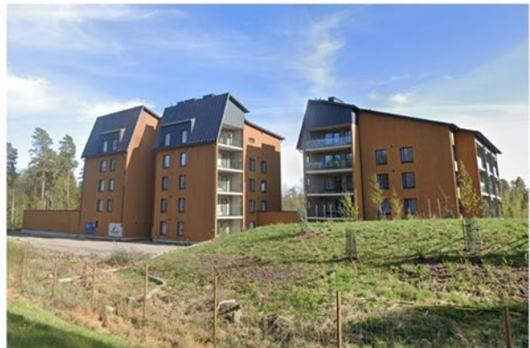
Uusia kerrostaloja Rymättylän tien varrella (Kuva: Google Street View 2025)
