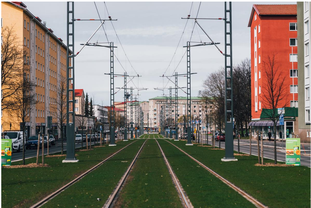
Viherrata Tampereen raitiotiellä Sammonkadulla. Kuva: Tampereen Raitiotieallianssi
