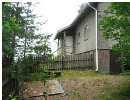
Eteläpäädyyn liittyvä piha-alue on aidattu puuaidalla.
