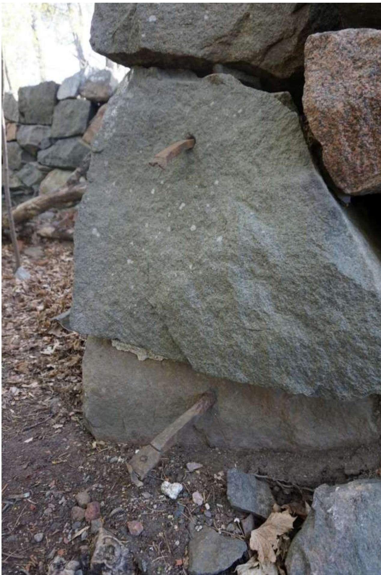
SKDG202202:40. Yksityiskohta eteläisen oviaukon itäreunasta, jossa on kaksi tukirautaa ja kivien välissä laastia.
