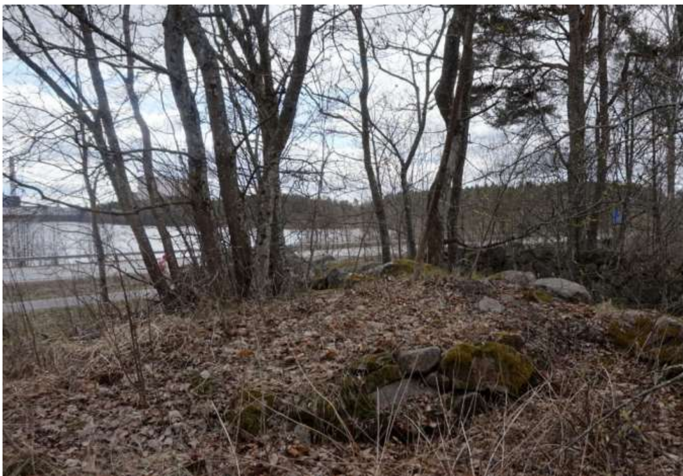
SKDG202202:30. Em. kivirakenteen ramppi sen itäisivulla.
