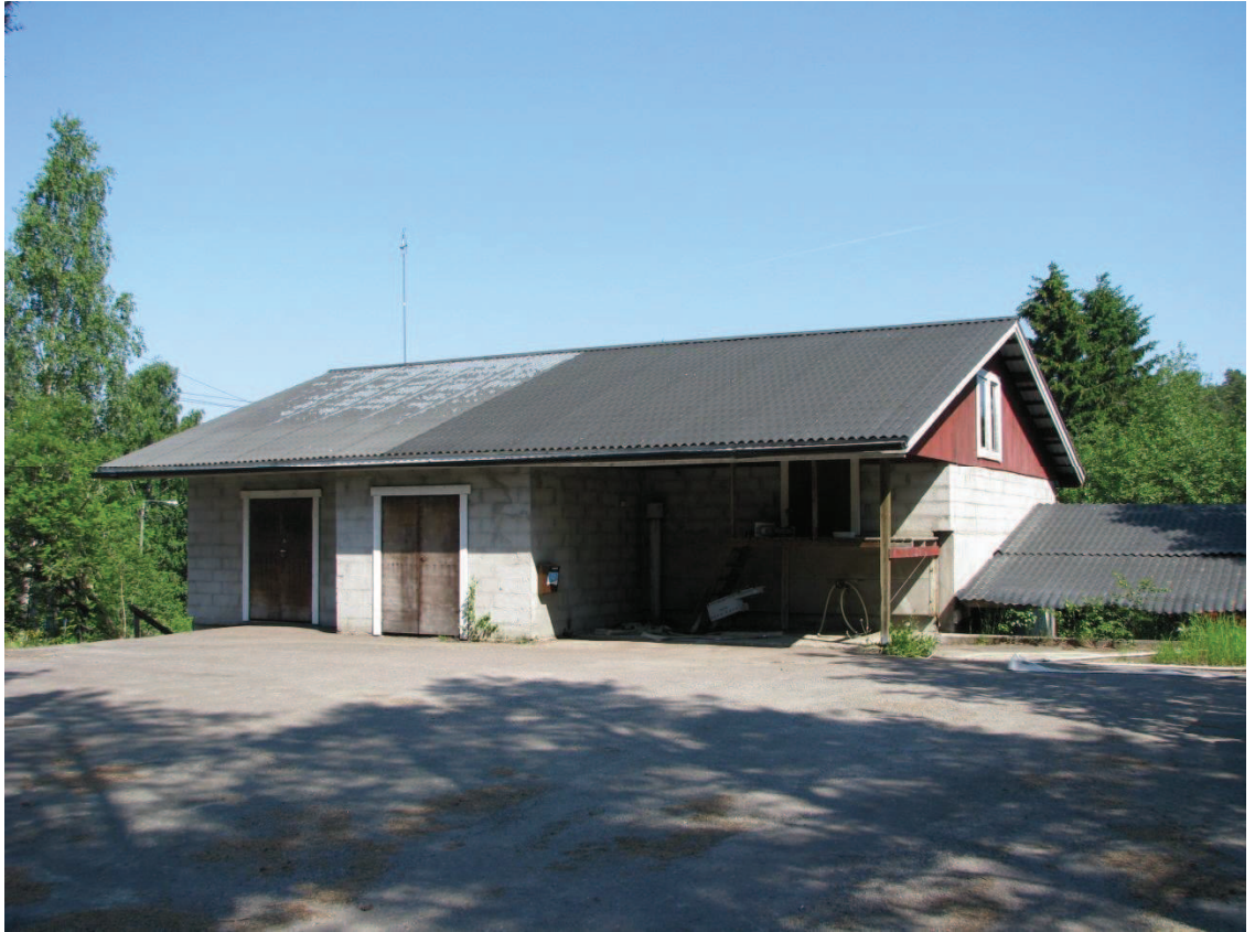
Kuva 12. Rymättylän vesilaitos, jossa on vedenottamon toiminta-aikana sekoitettu pohjavesi sekä järvestä otettu vesi.
