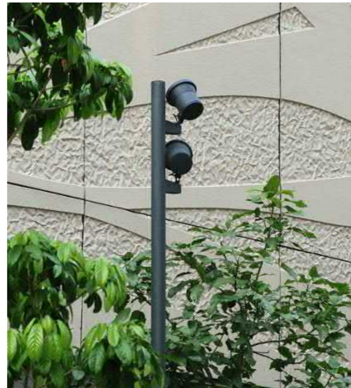
Kuva 20. Raittivalaisimiin saadaan lyhyellä lisävarrella kiinnitettyä puiden heitinvalaisimia.
