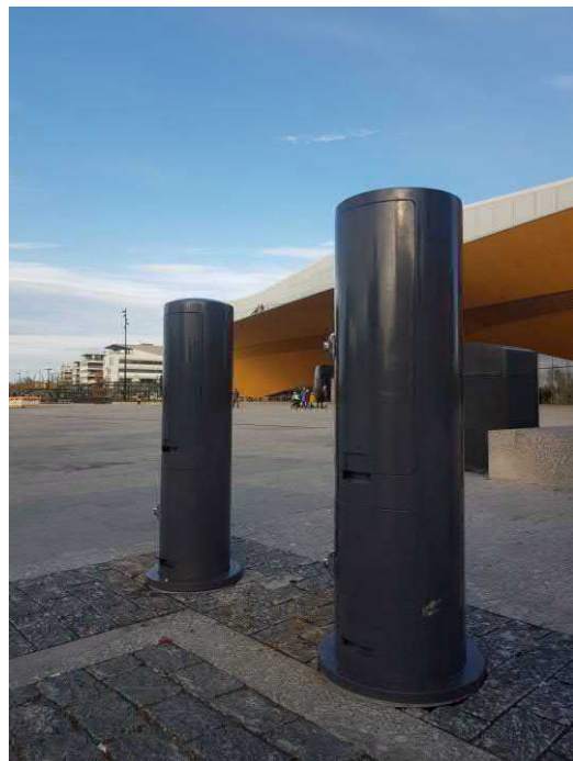
Kuva 54. Asennettuja tapahtumasähköpollareita.
