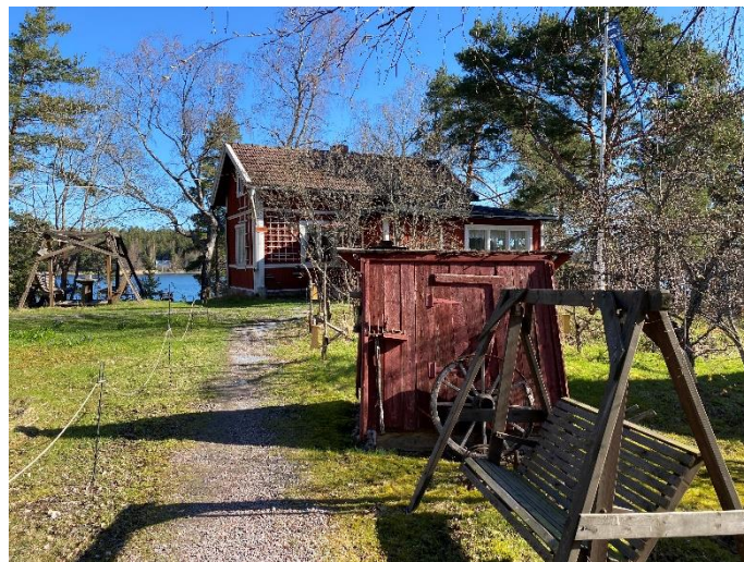
Voimassa olevassa asemakaavassa suojeltavaksi osoitettu rakennus (kalastajamökki).
