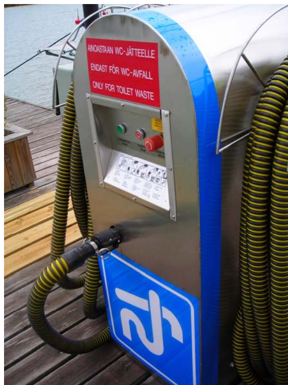
Kuva 6. Septitankin imutyhjennyslaite Merimaskussa.
